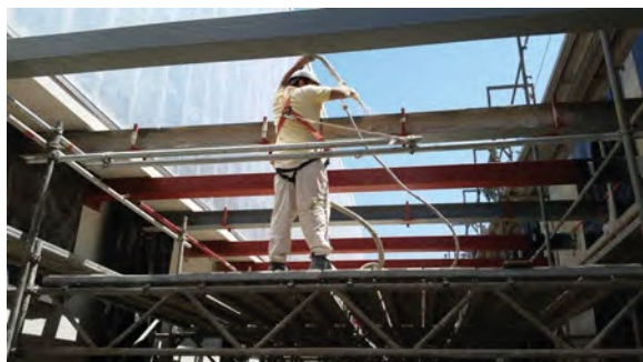
Aplicación en vigas.
