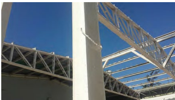
Aplicación en pilares y cerchas.
