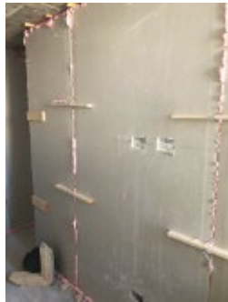
12) Dejar secar la espuma para Sello Espuma Volcán F120 por un periodo de 24 hrs
