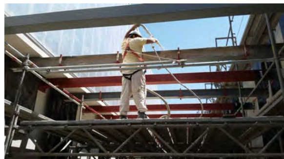
Aplicación en vigas.
