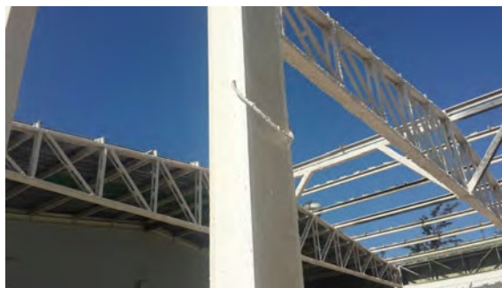
Aplicación en pilares y cerchas.
