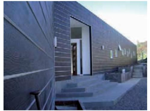
Son extensamente utilizadas en la construcción de viviendas y edificaciones comerciales para revestimiento interior de muros exteriores, división de espacios interiores y terminación de cielos. Este producto presenta múltiples ventajas constructivas como son la resistencia al fuego, el aislamiento acústico, su excelente desempeño mecánico frente a sismos, además de su facilidad y rapidez de instalación.
