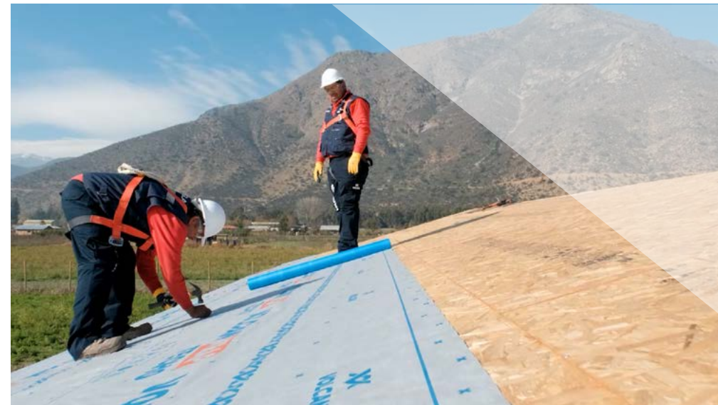
APLICACIÓN DE VOLCANWRAP TECHO
