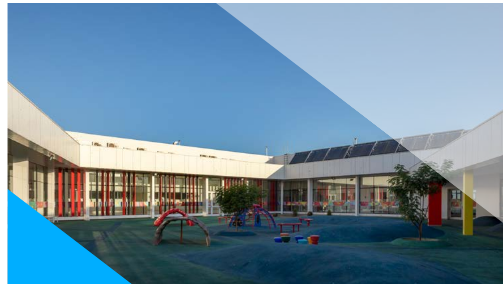
APLICACIÓN DE DURAFRONT EN EDIFICACIÓN EN COQUIMBO
