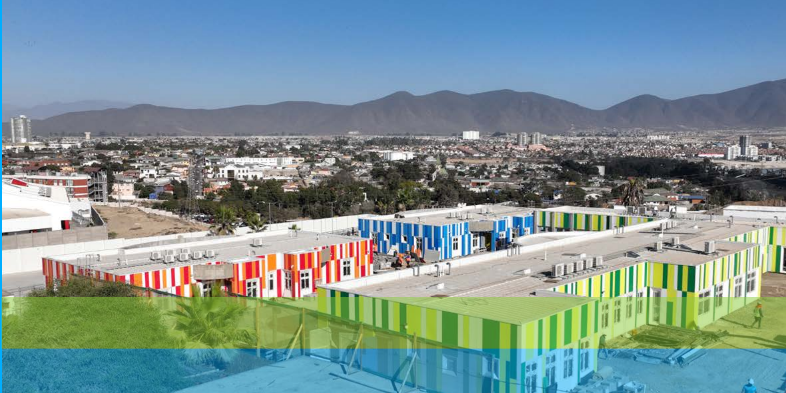
APLICACIÓN DE DURAFRONT EN PROYECTOS DE EDIFICACIÓN EN COQUIMBO
