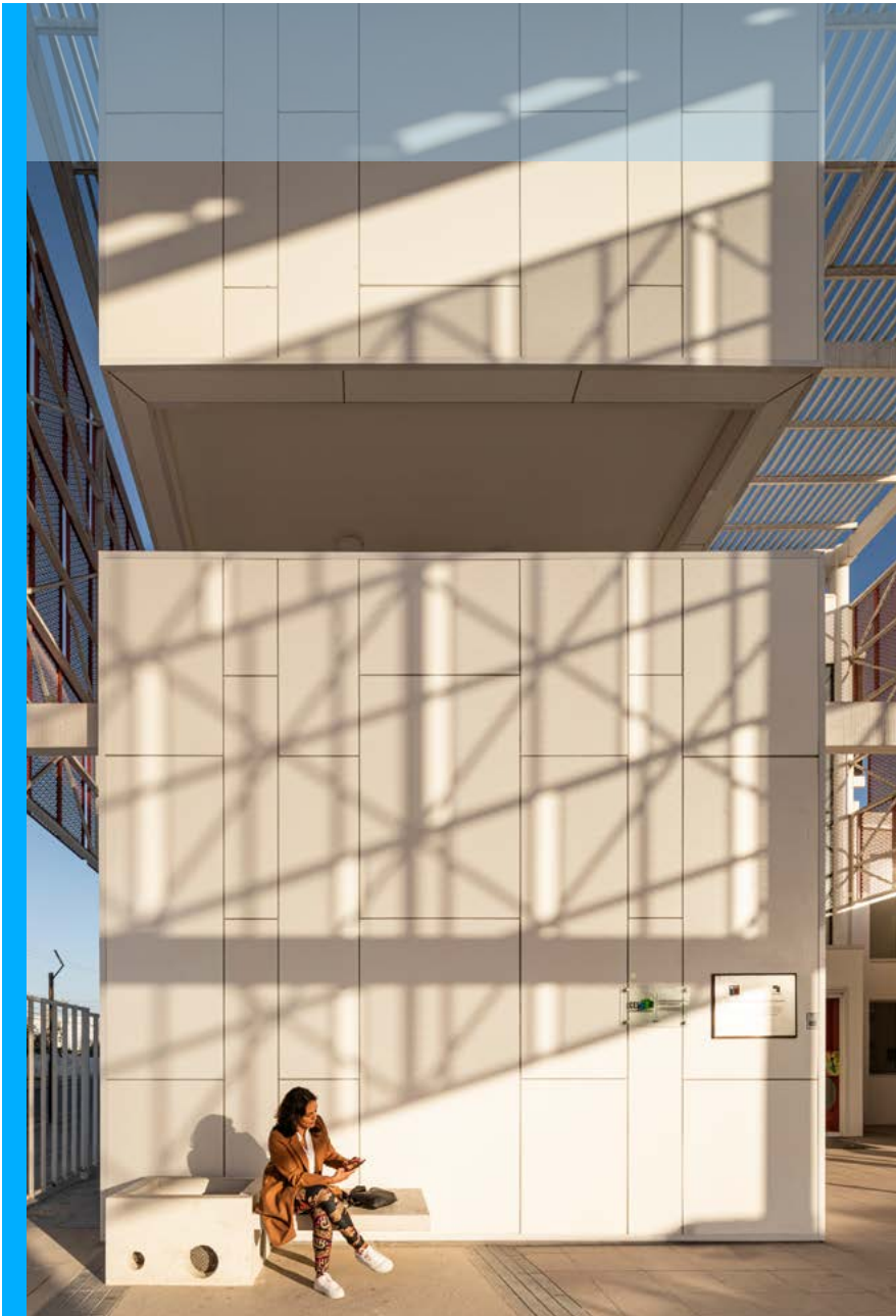
APLICACIÓN DE DURAFRONT EN EDIFICACIÓN DE COQUIMBO
