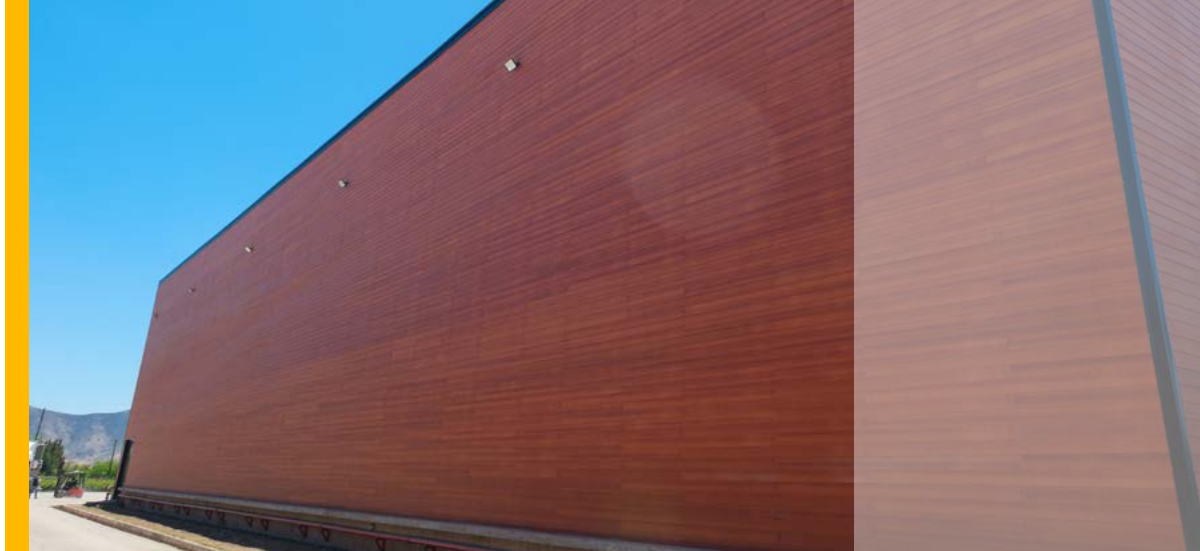
APLICACIÓN DE SIDING EN EDIFICACIÓN
