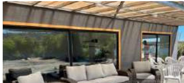
Placa para fachada, la cual permite contribuir al arriostamiento de la estructura. Otorga una terminación de veta madera machimbrada.
