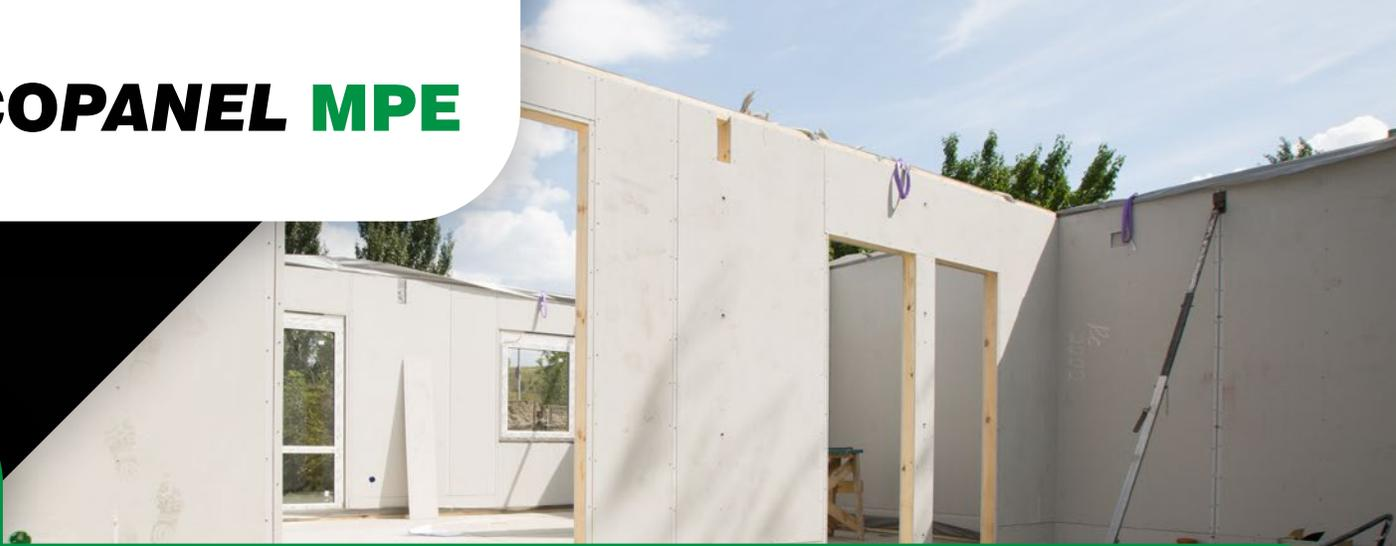
**SOLUCIÓN DE PANEL ESTRUCTURAL PARA CONSTRUCCIÓN INDUSTRIALIZADA, CON NÚCLEO DE POLIESTIRENO EXPANDIDO Y ESTRUCTURA DE MADERA, QUE ENTREGA MAYOR RAPIDEZ Y APORTA AL DESEMPEÑO TÉRMICO.**
