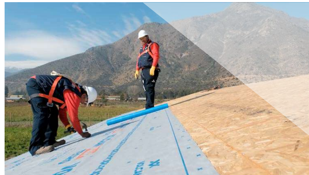
APLICACIÓN DE VOLCANWRAP TECHO
