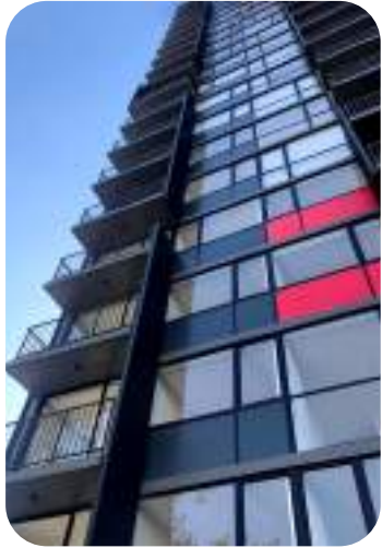
Edificio Fuenzalida Urrejola.
