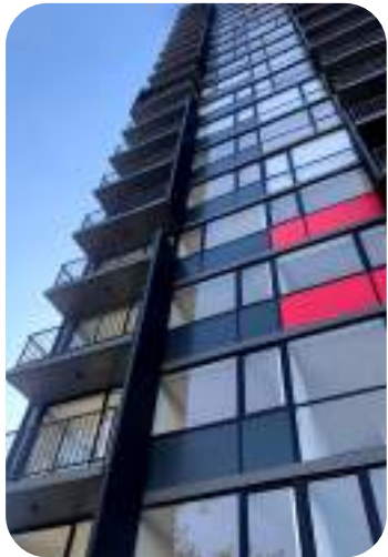
Edificio Fuenzalida Urrejola.
